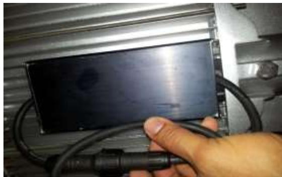
**Figura 62 Aseguramiento de la fuente de voltaje D.C. en la Luminaria Led**
