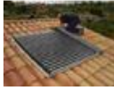
Figura 1.21. Colector termosifón
