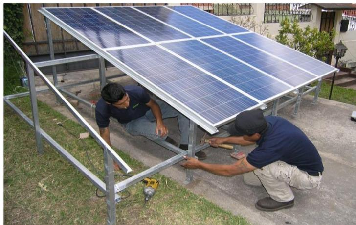
**Figura 3.6.** Estructura para el montaje de paneles fotovoltaicos en suelos.
