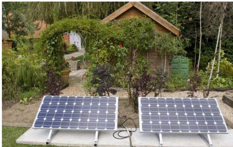
**Figura 2.8.** Colocación de paneles fotovoltaicos sobre el suelo.
