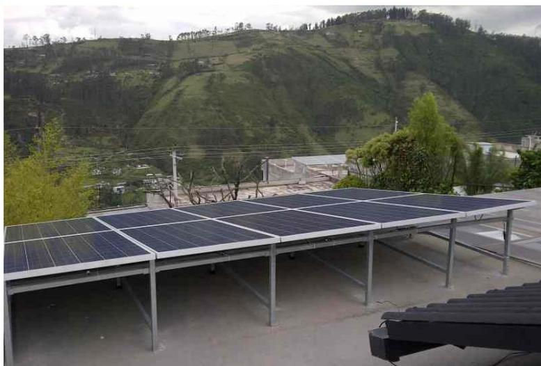
**Figura 3.7.** Soporte para el montaje de paneles fotovoltaicos en terrazas.
