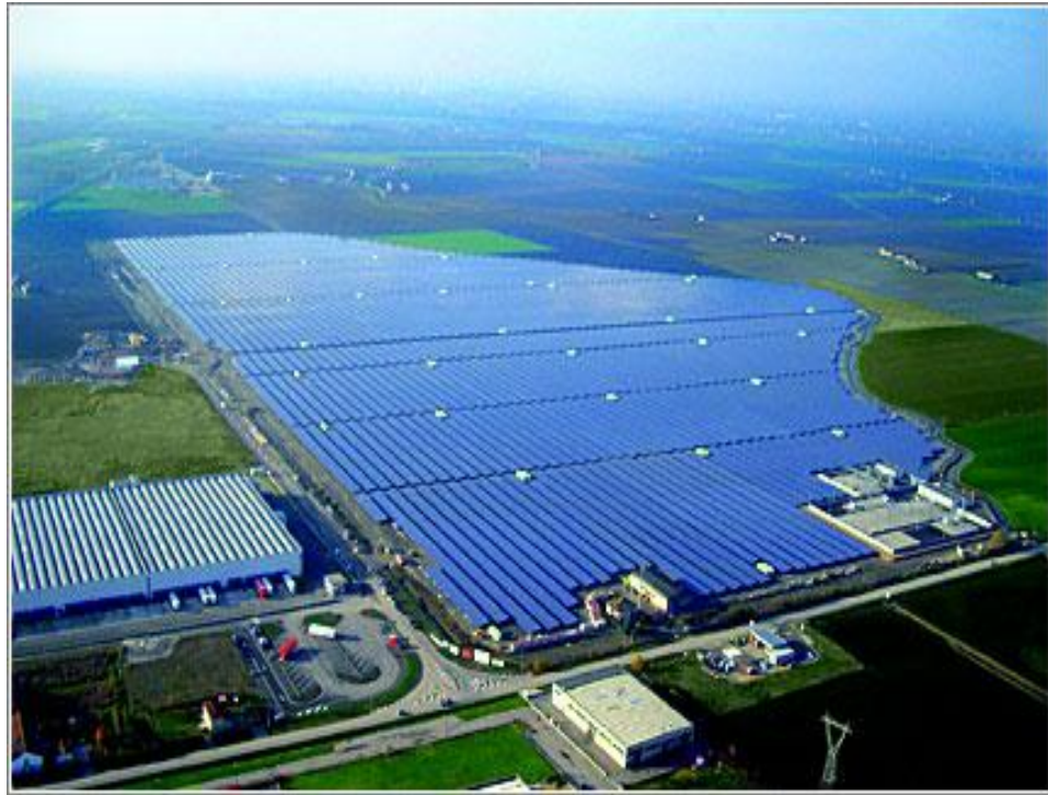
Figura 1.6: Foto aérea del Parque Fotovoltaico de Rovigo-Italia 12
