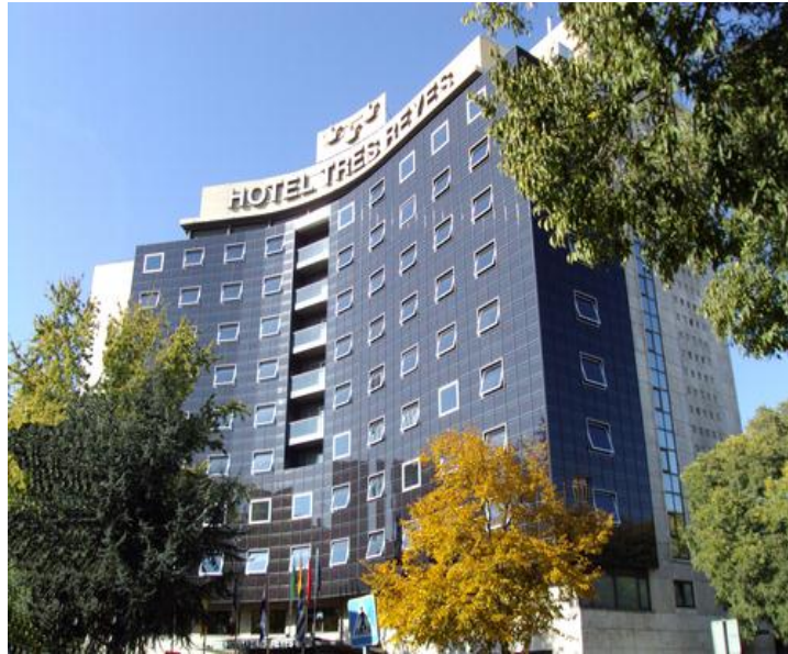
Figura 2. 14: módulos fotovoltaicos semitransparentes SCHOTT “ASI Thru” 36
