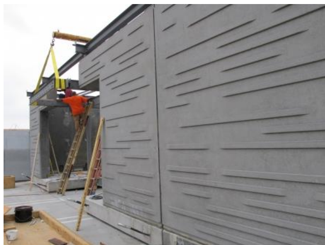
Figura 3 – Construção sustentável na Universidade de Carolina do Norte, Estados Unidos
