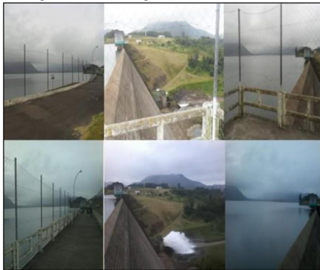
Figura 16. Barragem do rio São Bento.
