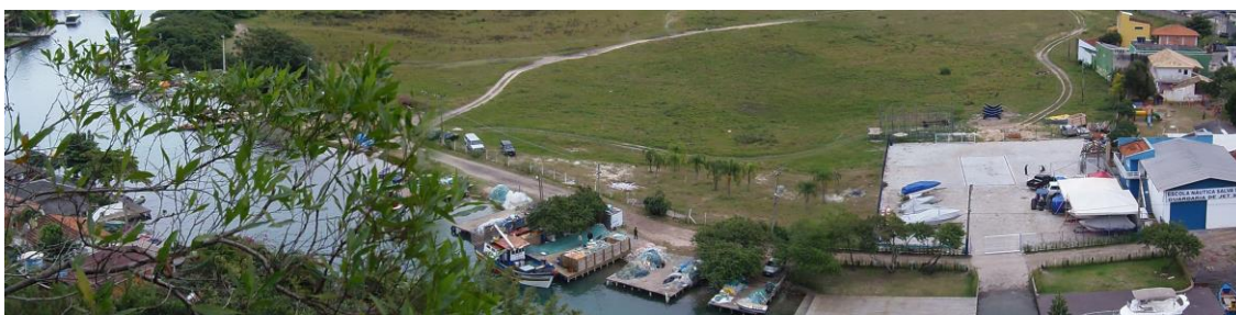
Figura 3 – Foto panorâmica da área impermeabilizada à beira do canal
