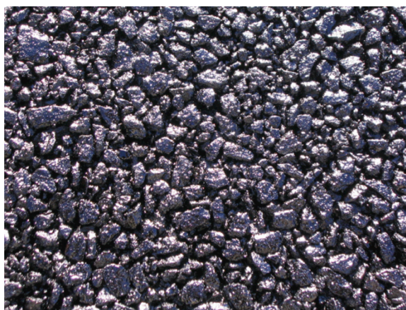
Figura 2.7 – Superfície de um concreto asfáltico drenante
