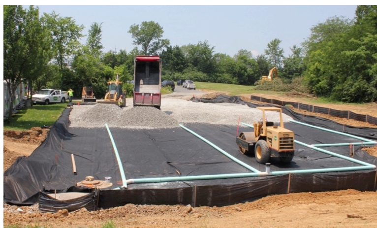
Figura 2.8 – Execução de um pavimento permeável
