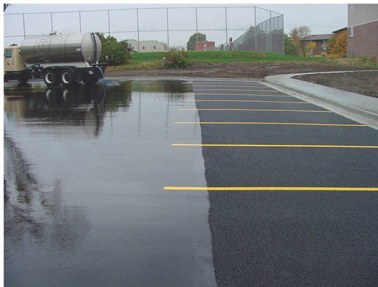
Figura 2.3 – Demonstração da eficiência do pavimento permeável em estacionamento
