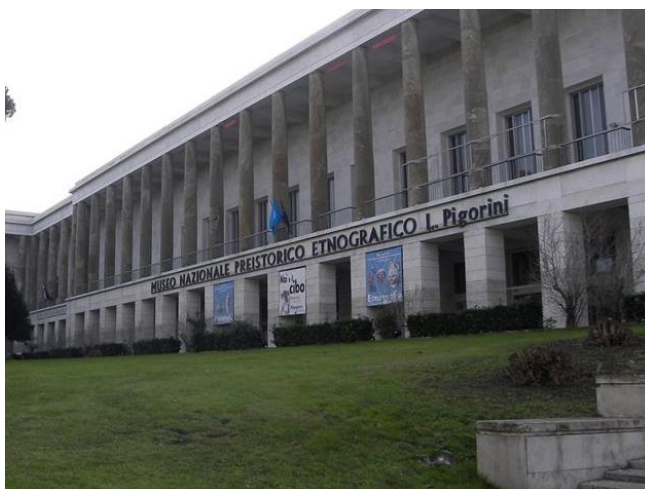
Figura 3: Fachada do museu
