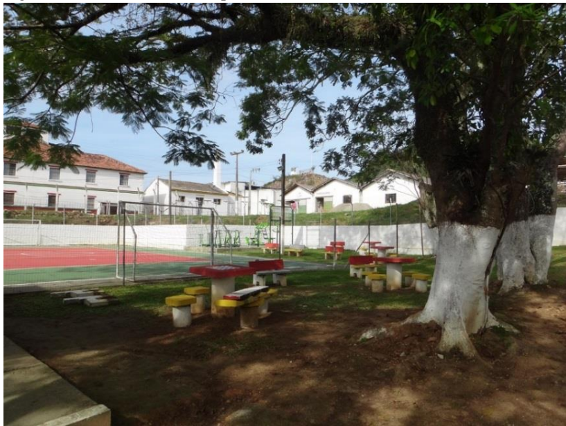
Figura 2 - Pátio externo do hospital de custódia (antes da reforma).
