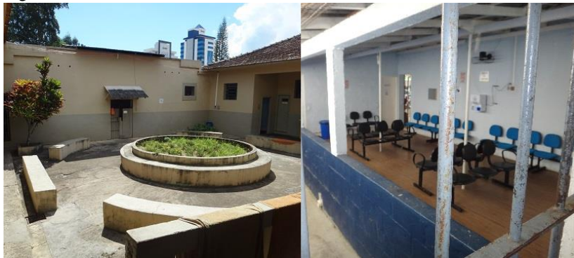
Figura 11 - Pátio das enfermarias e sala de visita.
