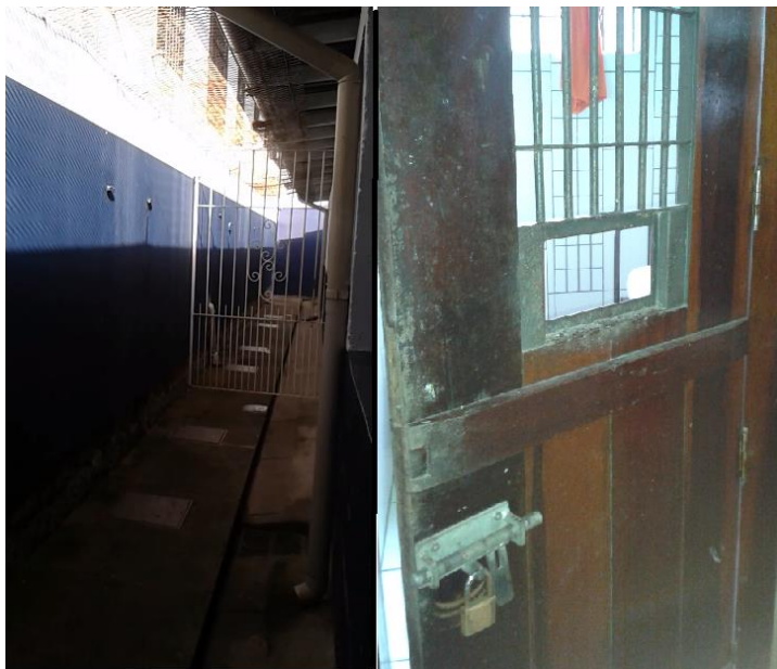
Figura 10 - Acesso restrito e estrutura defensiva nos leitos.
