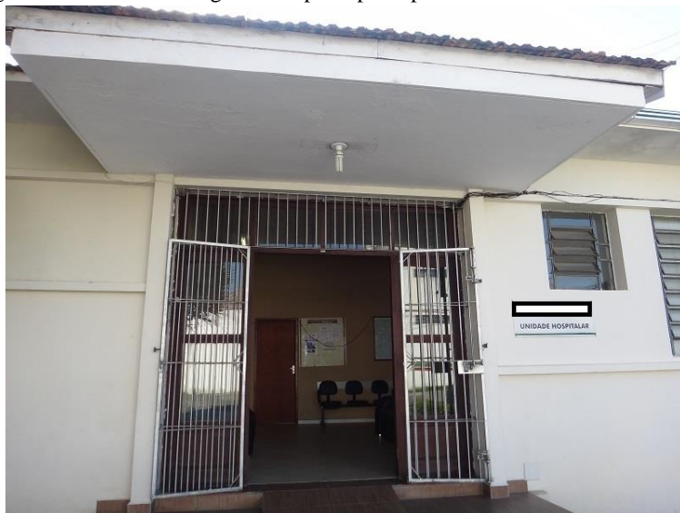
Figura 13 - Fachada com grades na porta principal.
