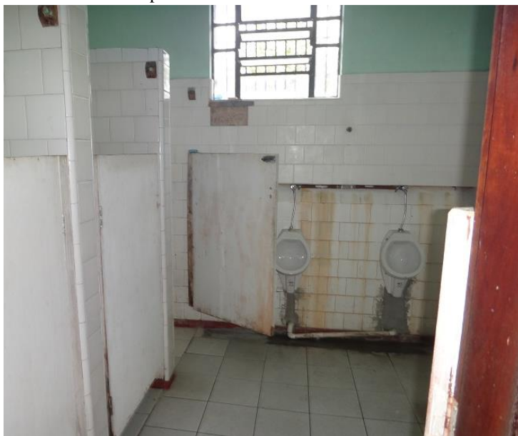
Figura 12 - Banheiro do primeiro corredor.
