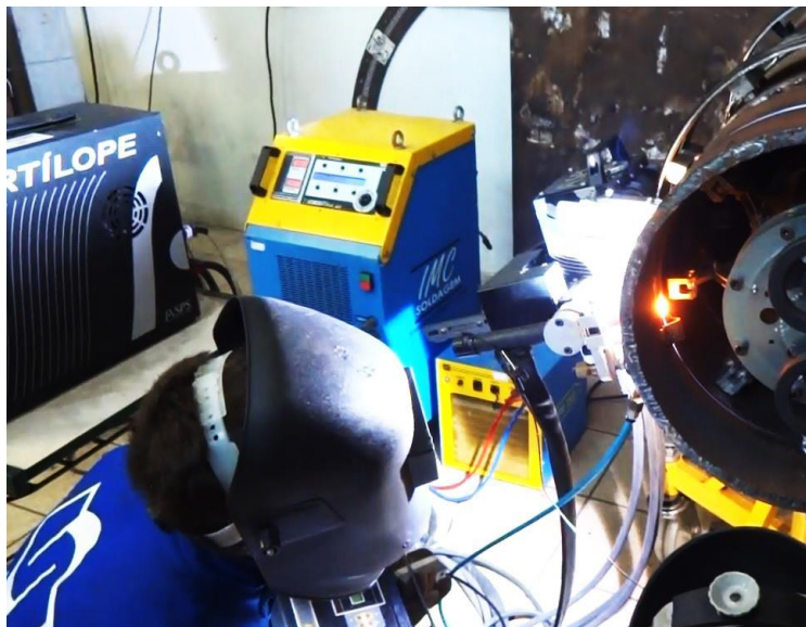
Figura 53. Acompanhamento do procedimento durante a soldagem.
