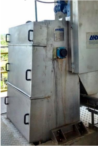
Figura 47: Gradeamento mecanizado com peneiramento grosseiro e fino.
