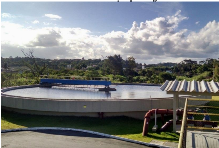
Figura 26: Decantador secundário. Vista da edificação do reator de lodos ativados aeração prolongada.
