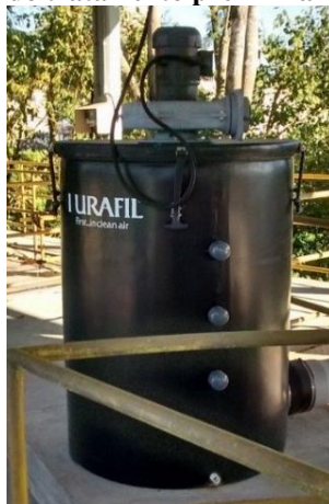
Figura 18: Tratamento de odores do tratamento preliminar.
