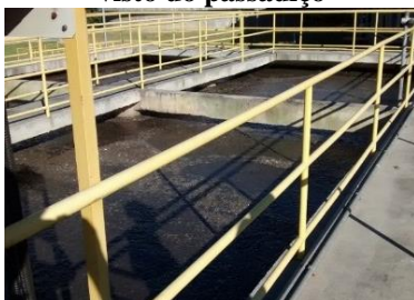
Figura 23: Tanque de aeração visto do passadiço
