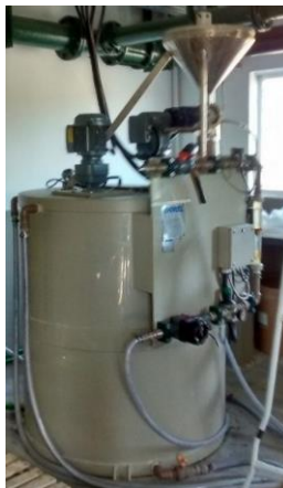
Figura 29: Dosador de polímero para tratamento do lodo.
