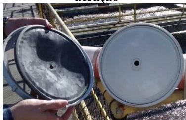
Figura 24: Difusor de bolhas finas utilizado no tanque de aeração
