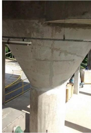
Figura 48: Desarenador do tipo vórtex
