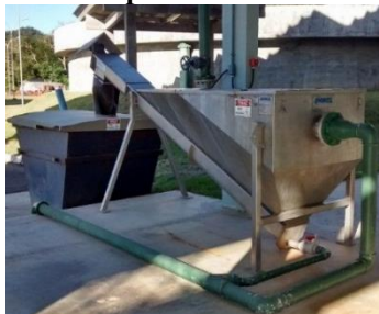
Figura 20: Classificador de areia acoplado à caçamba para destinação da areia removida do preliminar.
