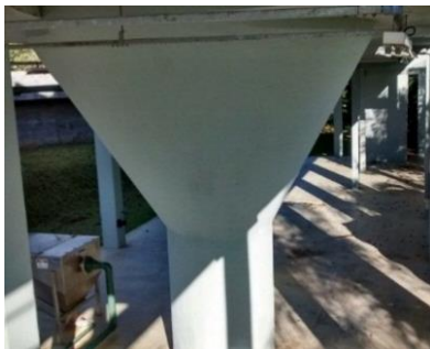
Figura 19: Desarenador tipo vórtex em concreto armado.
