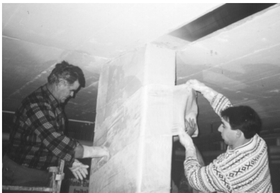
Fig. 8 – Toepassing ‘wet lay-up’ systeem
