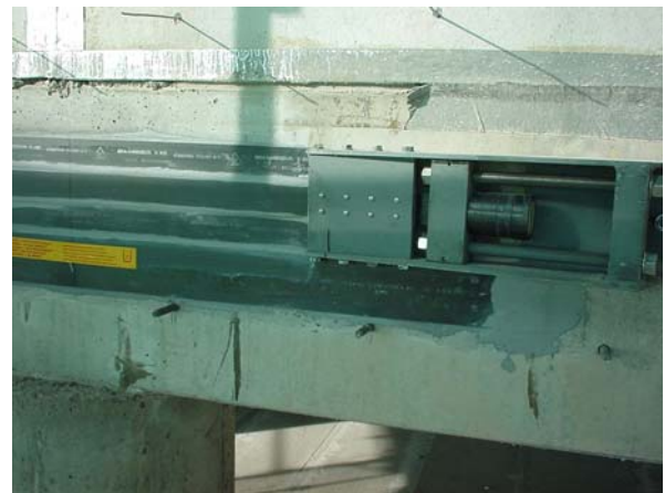
Fig. 9 – Toepassing voorgespannen FRP (Amsterdam, Nederland)
