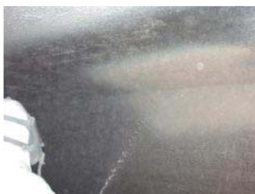
Fig. 11 – Toepassing van SFRP
