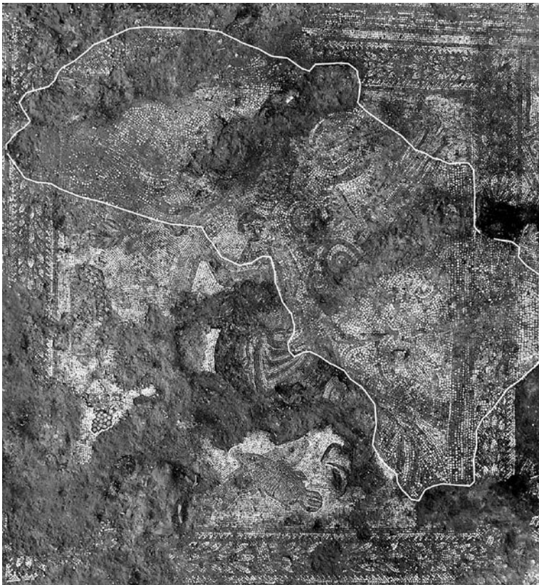
Fig. 3 – Ortofoto del pannello centrale: la linea bianca circoscrive l'area del rifacimento successivo alla stesura iniziale.
