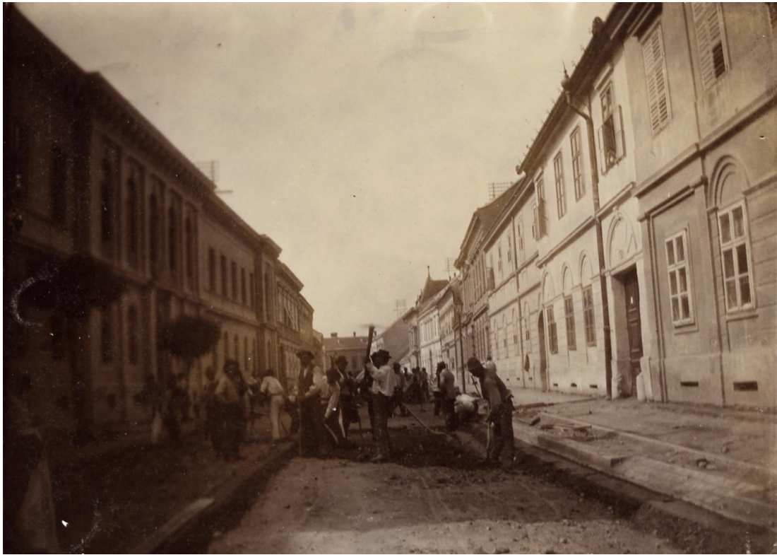
22. KÉP ÚTÉPÍTÉS A SZILY JÁNOS UTCÁBAN
