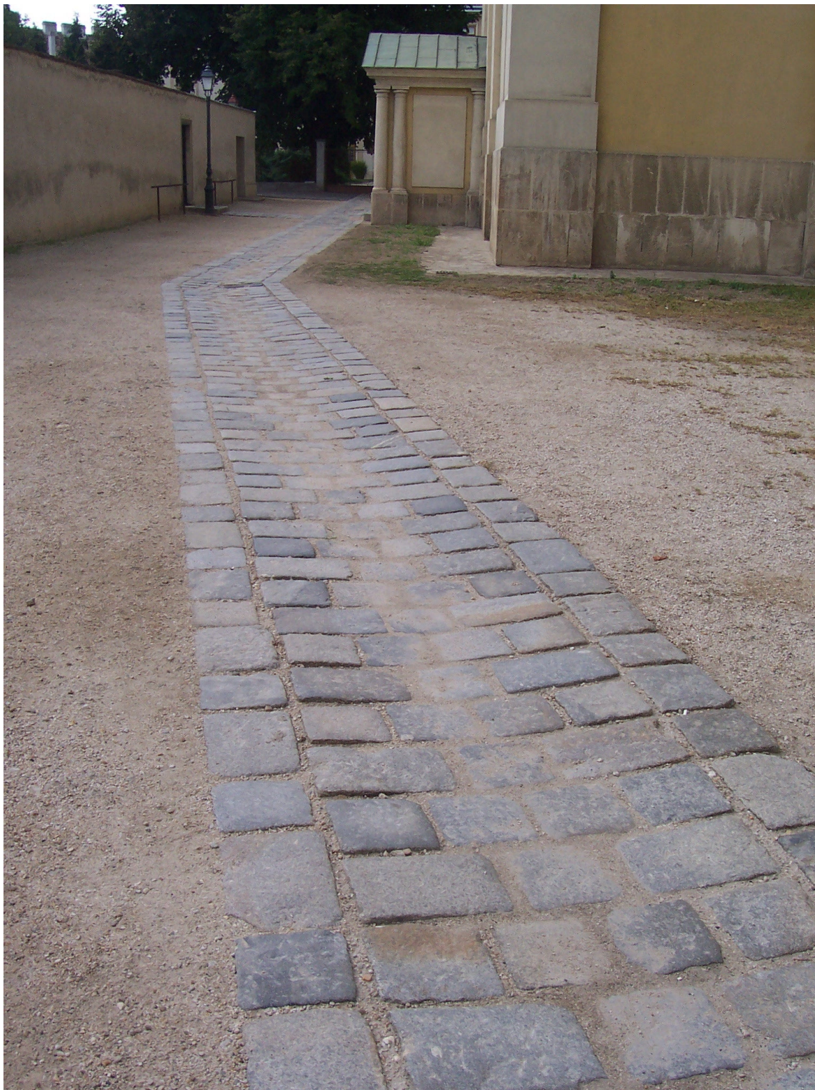
17. KÉP FELSZEDETT GRÁNIT KOCCAKŐ JÁRDÁK ANYAGÁBÓL UTÓLAGOSAN KÉSZÍTETT GYALOGJÁRÓ NAPJAINKBAN, A SZÉKESEGYHÁZ OLDALÁN
