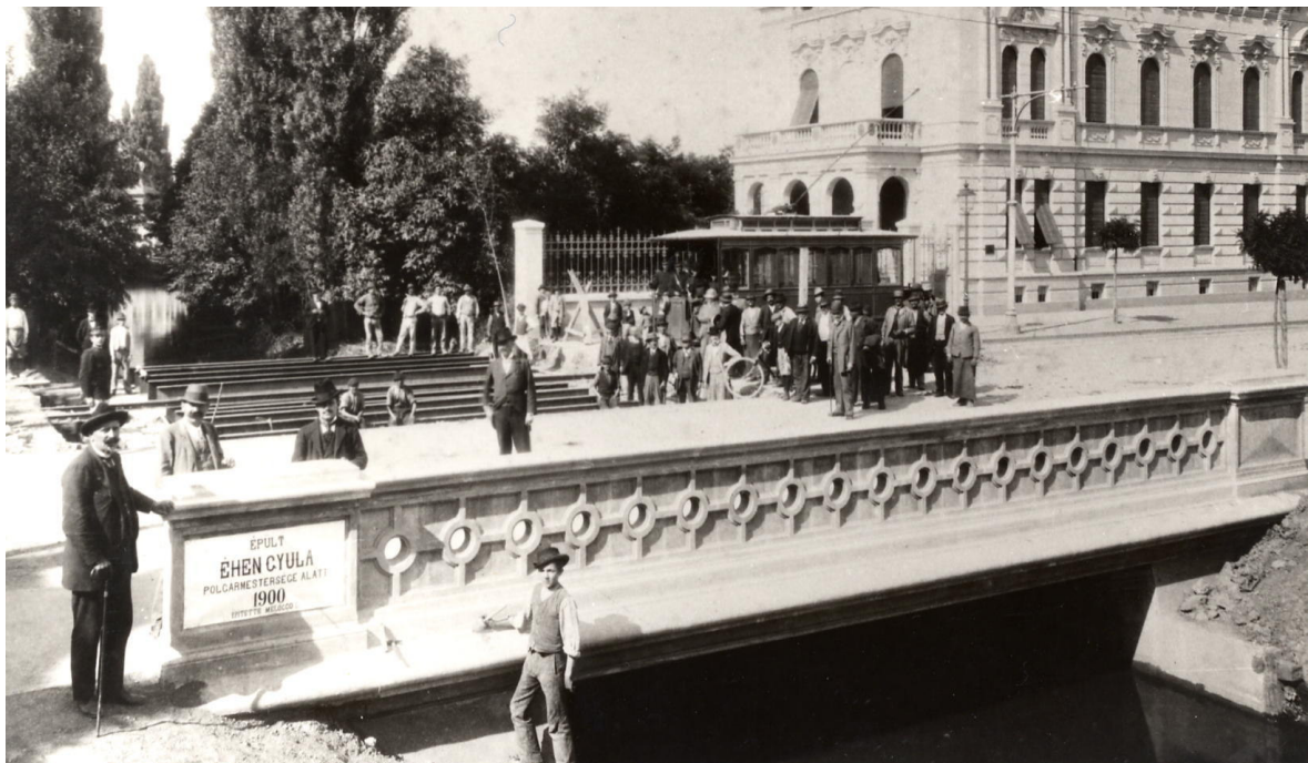
25. KÉP A SZÉLL KÁLMÁN UTCAI BETONHÍD ÉPÍTÉSE (1900)
