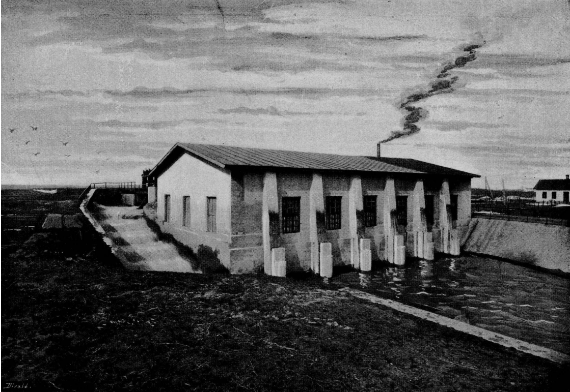
7. KÉP AZ IKERVÁRI VÍZERŐMŰ TURBINAHÁZA (1890-ES ÉVEK VÉGE)
