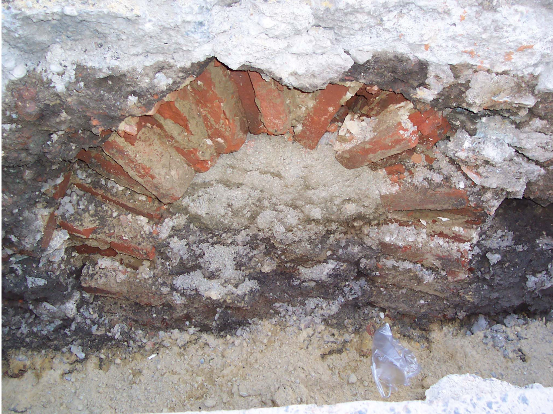
11. KÉP EGYKORI FALAZOTT CSATORNA MARADVÁNYA NAPJAINKBAN (KŐSZEGI UTCA)
