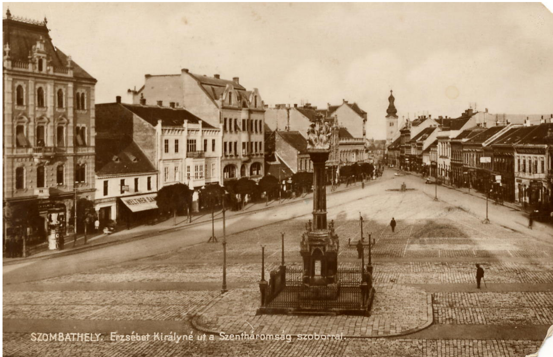
26. KÉP A FŐ TÉR ASZFALT ÉS GRÁNIT KOCCAKŐ BURKOLATA
