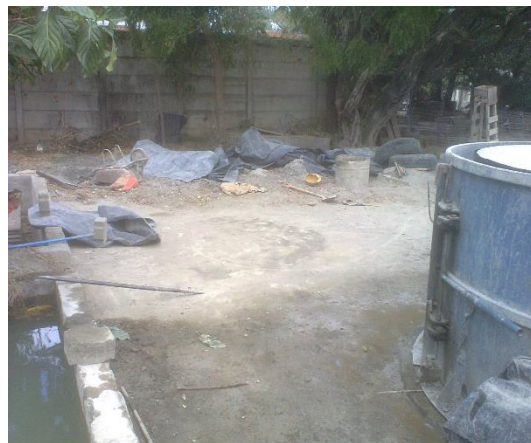
Foto 6. Mezcla de materia prima
