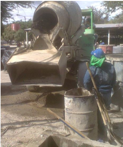
Foto 15. Descarga de mezcla
