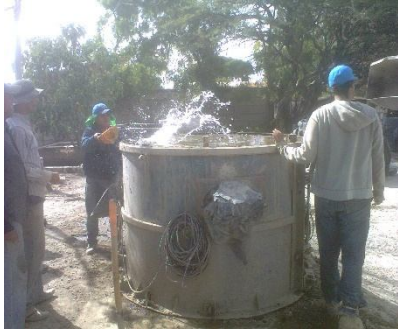
Foto 13. Mezcla del concreto
