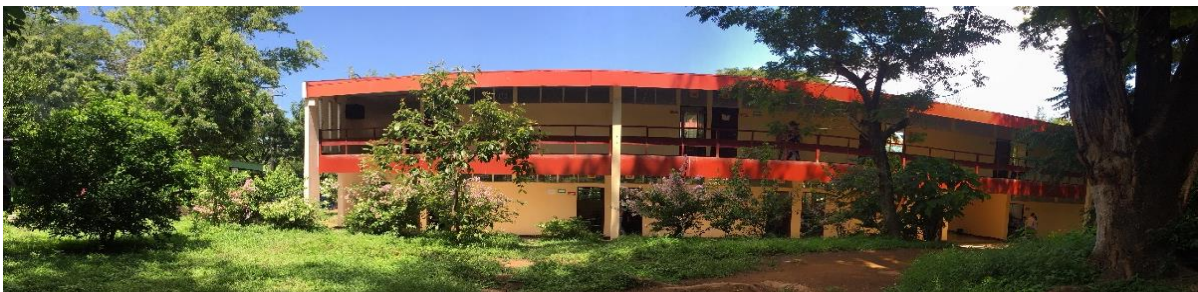
Imagen N° 33. vista panorámica pabellón 60. Fuente propia.
