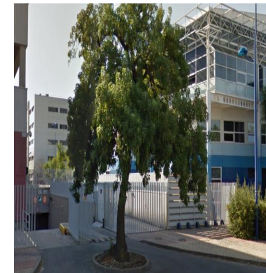
Vista desde la calle de la entrada al sótano.
