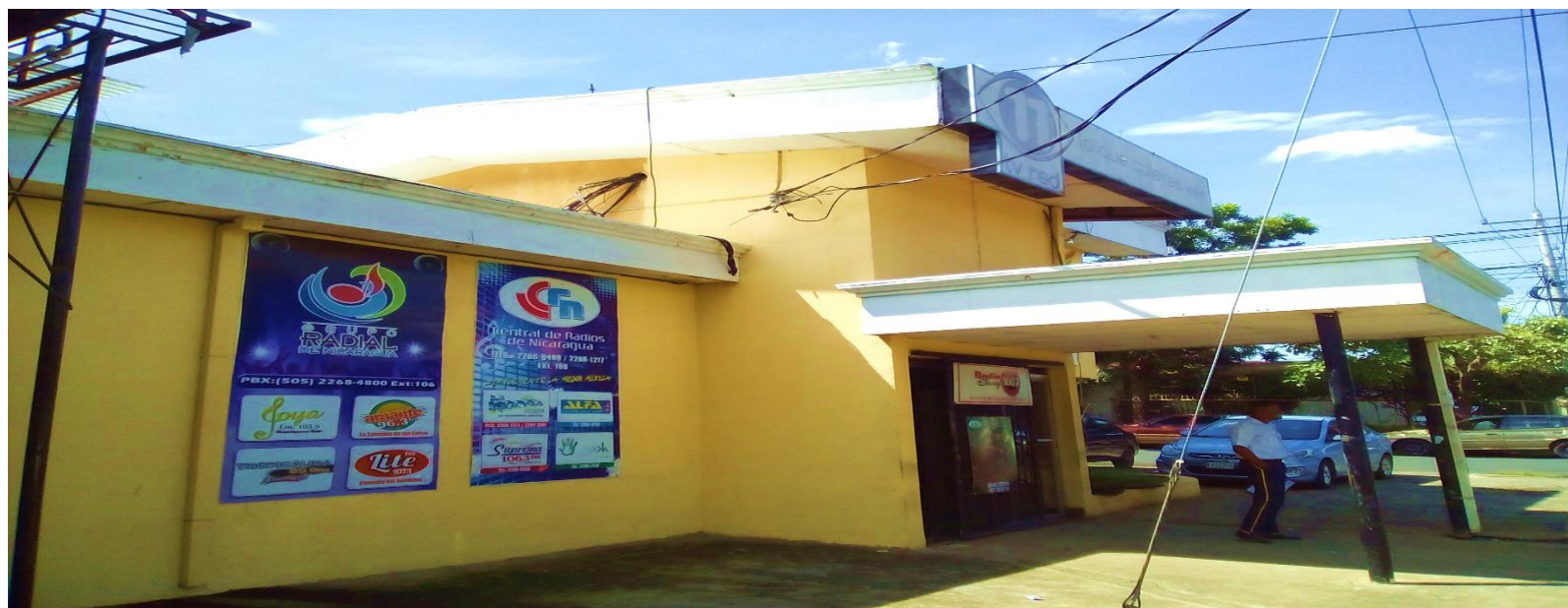
Vista exterior de cabinas radiales grupo Ratensa. Fuente propia
