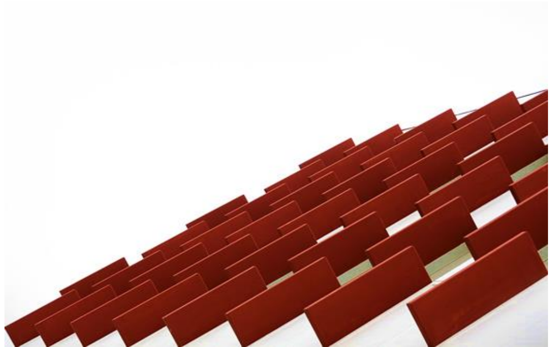
Elementos rojos de las ventanas de la fachada
