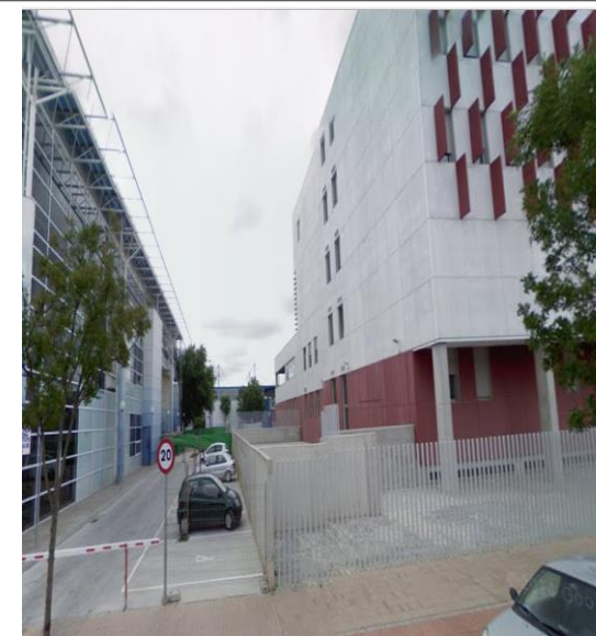
Vista externa del estacionamiento.
