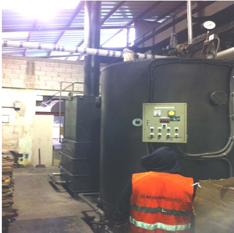
Ilustración 1 Maquina Propuesta (Caldera de Biomasa)
