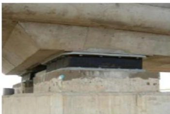
Aislador con centro de Plomo
