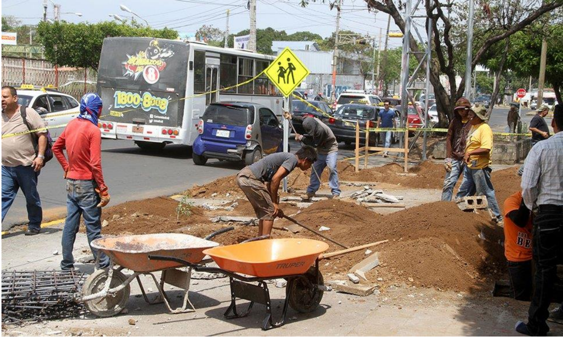
Imagen N°4: construcción de una parada de autobuses.
