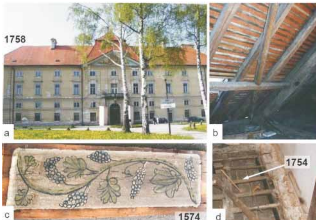
Slika 3: Jelovina v konstrukcijah: (a, b) dvorec Novo Celje, kjer so datirali ostrešje in stropne konstrukcije (datum zadnje branike 1758); (c, d) grad Pišece, poslikani strop (datum zadnje branike 1574) in talna konstrukcija (datum zadnje branike 1754).
