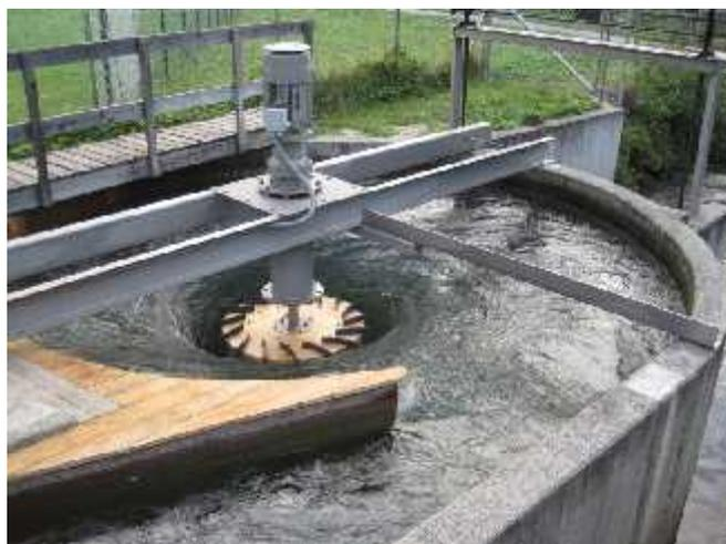
Abbildung 7: Gravitationswasserwirbelkraftwerk
