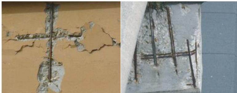
Figure 2.3 : Exemple d'enrobages trop faibles menant à la corrosion
