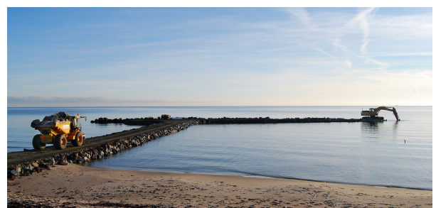
Figure 3.4 — Brise-lames en construction (tiré de Wikipédia, 2016b)
