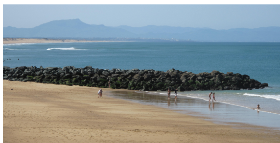
Figure 3.3 — Épi de roche (tiré de Wikipédia, 2016b)
