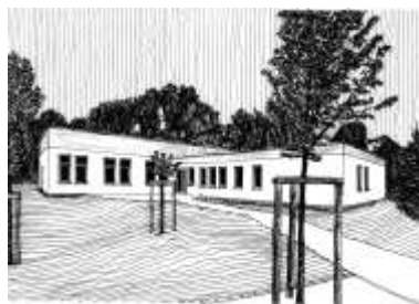
Modulární kulturní dům v Rybníku o ploše 324 m 2 je tvořen 10 velkoformátovými moduly, přičemž sál, který je složen ze 6 modulů, má světlou výšku 4,3 m. Pro zázemí kulturního domu, které obsahuje kuchyňku, WC, sklady a klubovnu, byly použity 4 standardně vyrobené moduly se světlou výškou 2,8 m.
