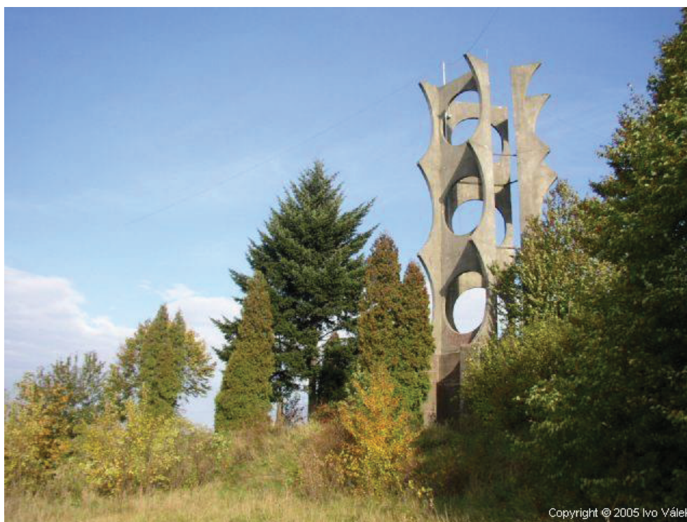
Obr. č. 4 Vodojem Krmelínu, zdroj: [23]
