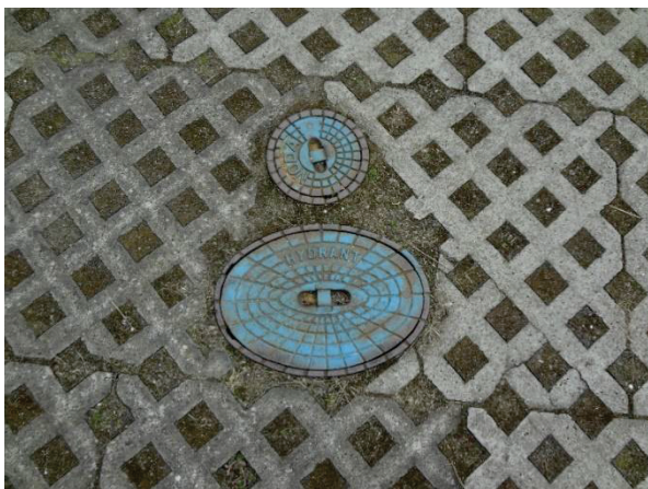
Obr. č. 5 Hydrant +uzávěr, zdroj: vlastní
