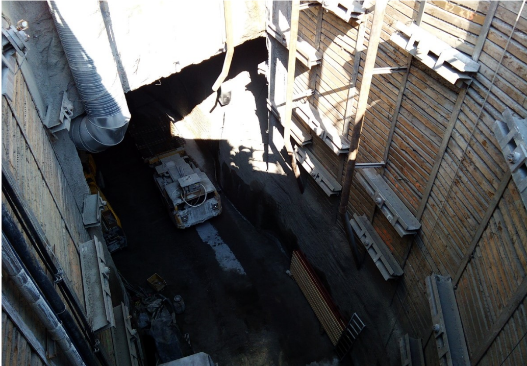
Obr. 21 – Pohled do těžní šachty [foto: T.Pospíšil 2016]
