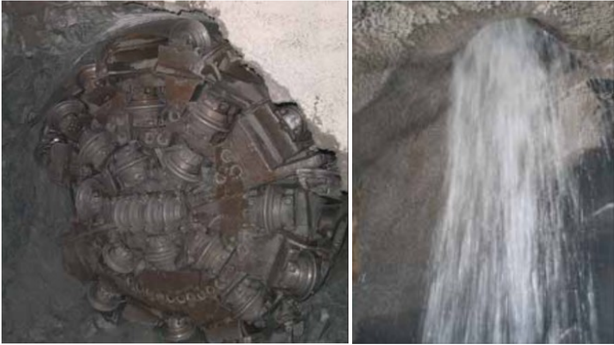
Obr. 17 – Řezná hlava TBM a výrony vody na průzkumné štolé Višňové [18]
