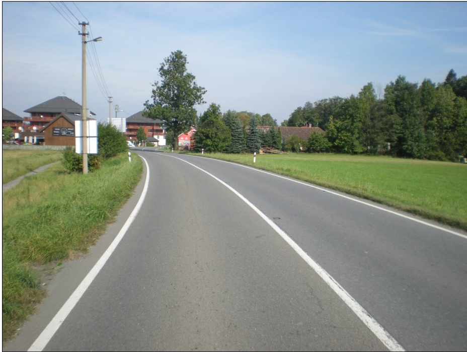
Stávající vedení silnice II/483 v nezastavěném území
