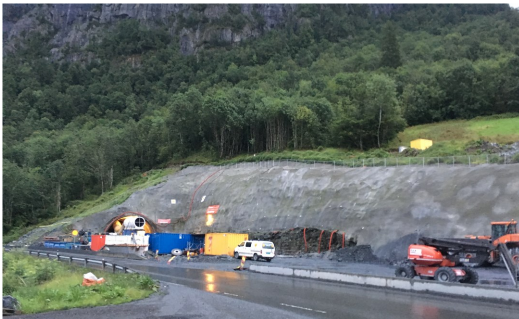
Obr. 12: Pohled na jihovýchodní portál tunelu v morénovém svahu
