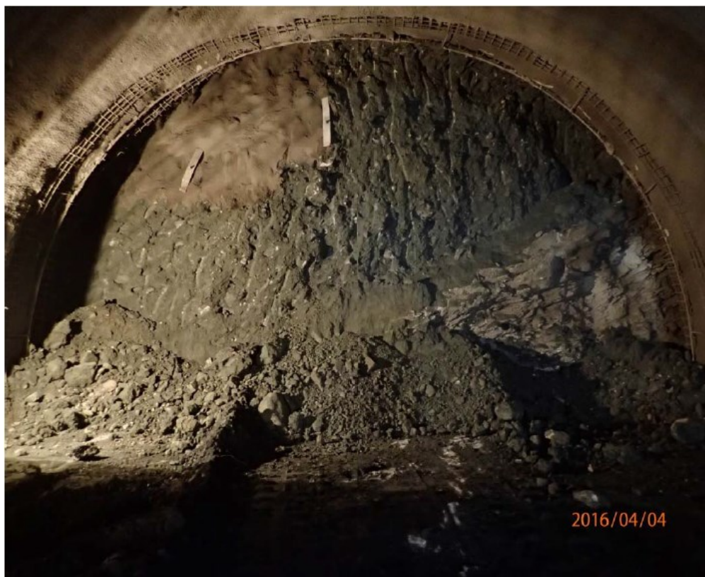
Obr. 33: Fotografie geologické dokumentace čelby v kalotě řezu č. 2 [13]
