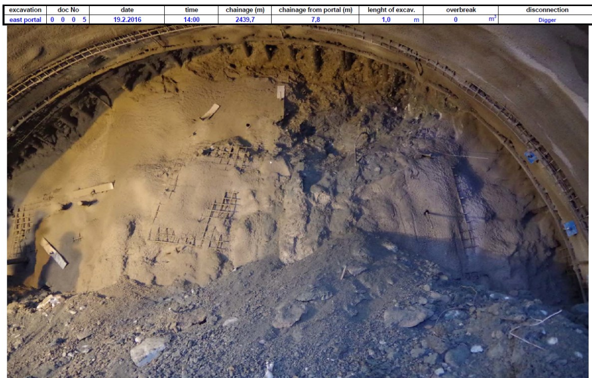
Obr. 28: Fotografie geologické dokumentace čelby v kalotě řezu č. 1 [13]
