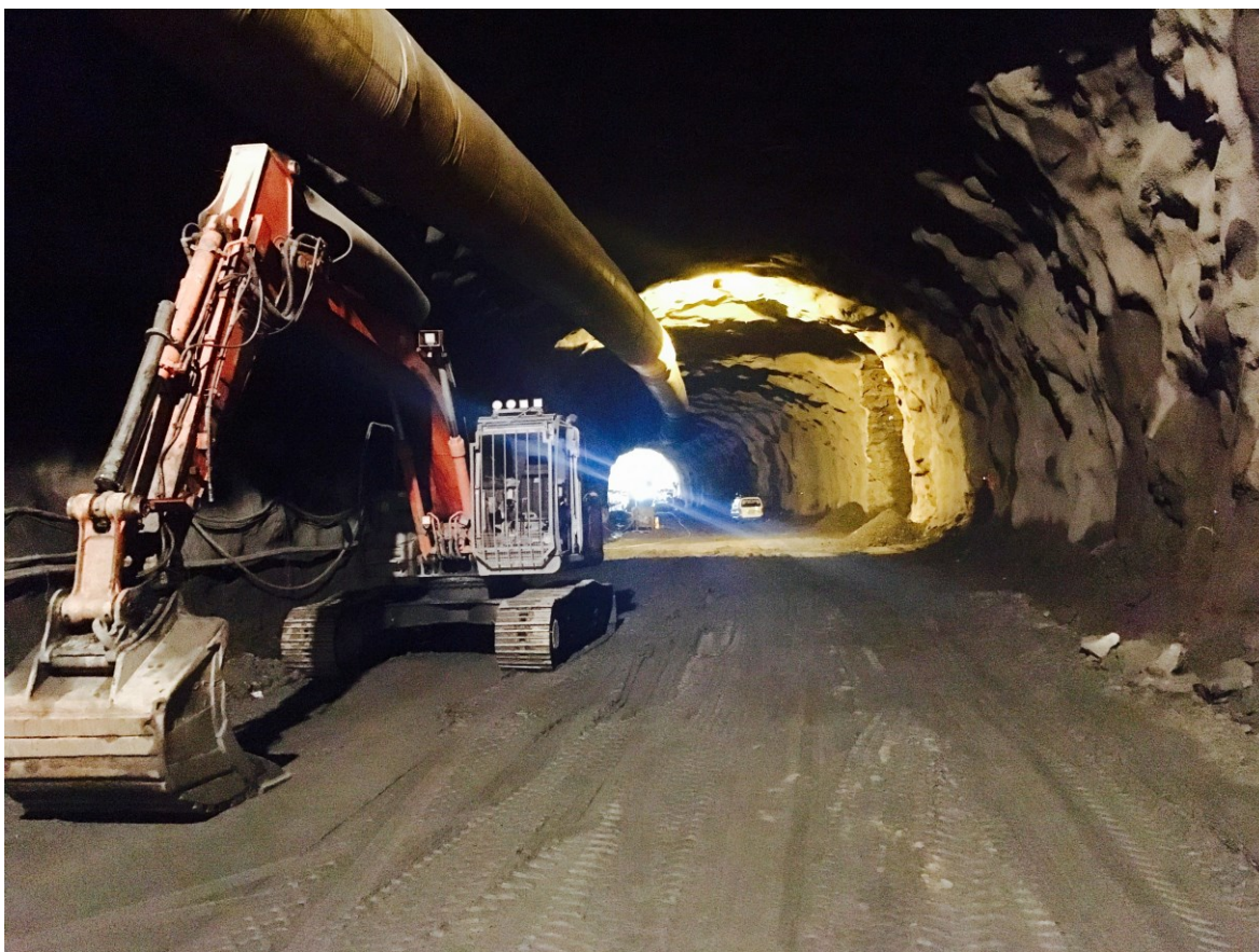
Obr. 14: Pohled z vnitřní části tunelu směrem k portálu od přechodu mezi metodami NRTM a D&B
