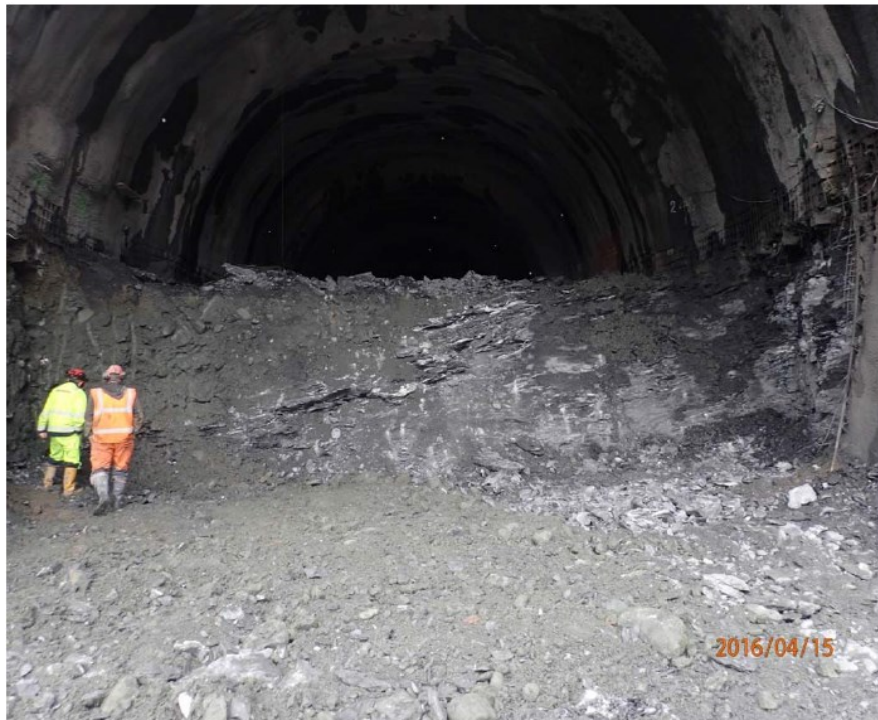
Obr. 30: Fotografie geologické dokumentace čelby v jádru řezu č. 1 [13]
