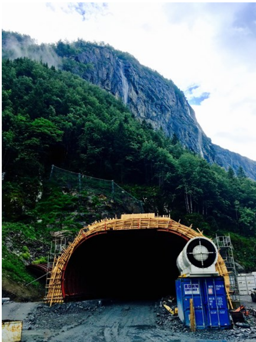
Obr. 4: Pohled na západní portál poblíž obce Øvre Vassenden
