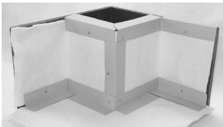
Obr.č. 12: opracování atiky spojovacími plechy [15]
