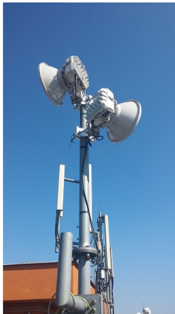
Obrázek 11: Vyměněná jednotka na stožáru
