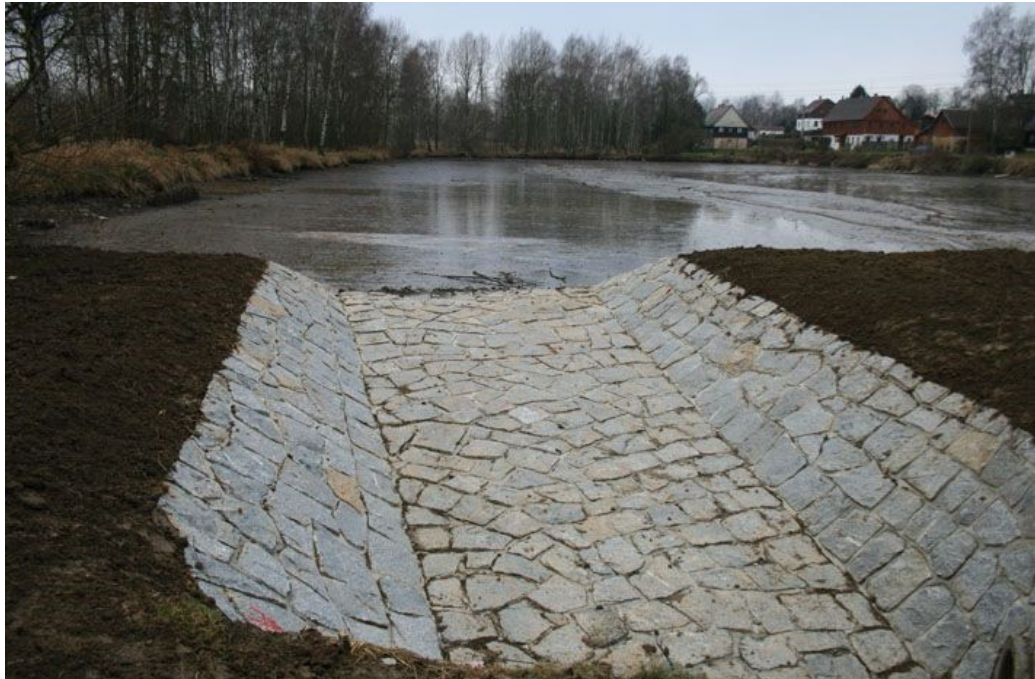
Obrázek č. 8 – Bezpečnostní přeliv umístěn v koruně hráze. [31]
