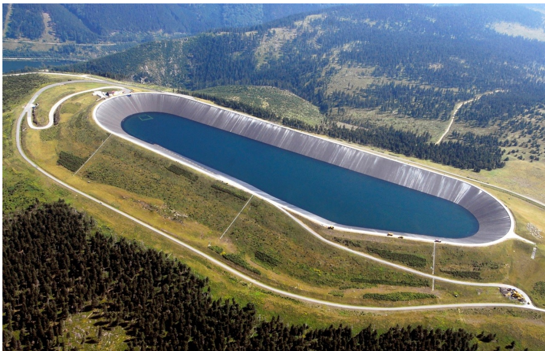
Obrázek č. 3 – Příklad obvodové hráze (Dlouhé Stráně). [29]
