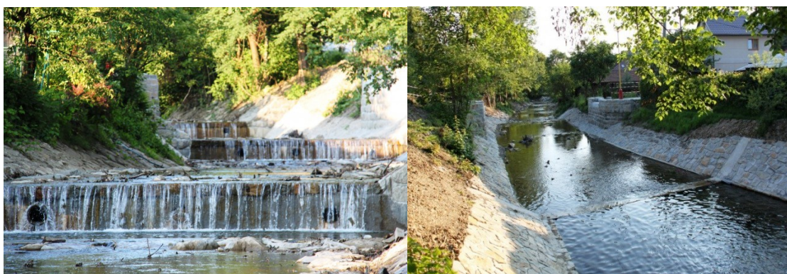
Obr. 3 Oprava koryta potoka Jasenice [6]
