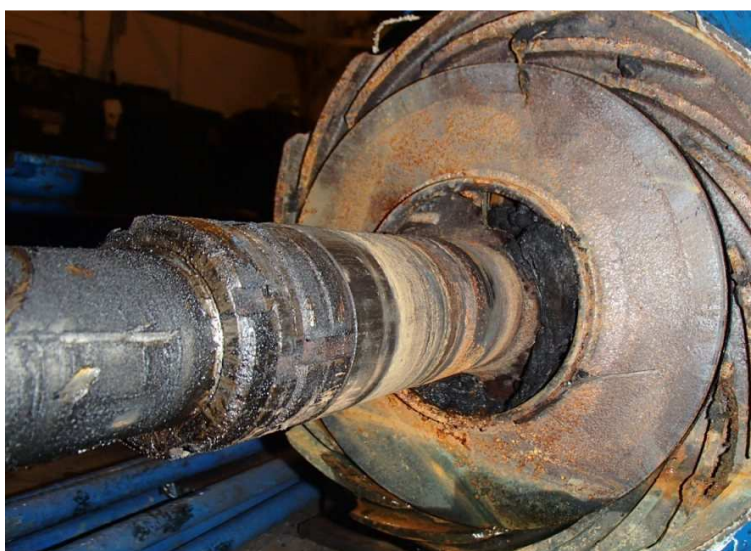
Obrázek 17 Pohled na ucpané vstupní oběžné kolo
