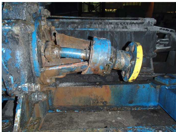
Obrázek 15 Utržené těleso ložiska
