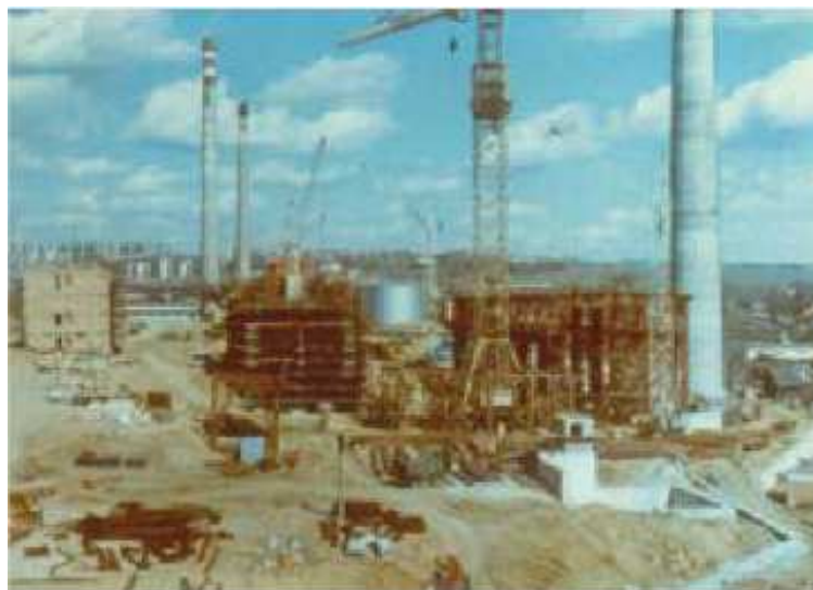
Obr. 3 Budování nové spalovny [3]
