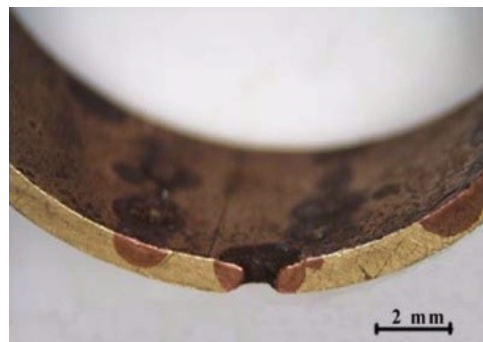
obr. č. 16 – Selektivní koroze v praxi. [7]
