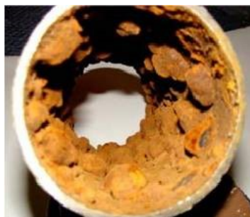
Obrázek č. 30 – Potrubí, které sloužilo k odvodu chladících vod [15]
