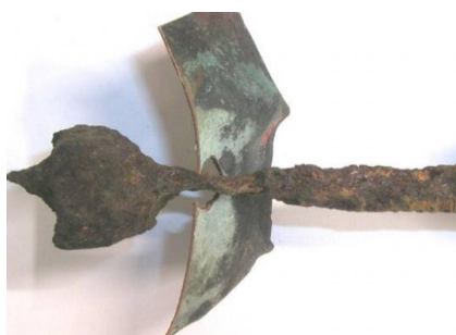
Obrázek č. 32 – Koroze železného šroubu v místě měděného pláště [21]
