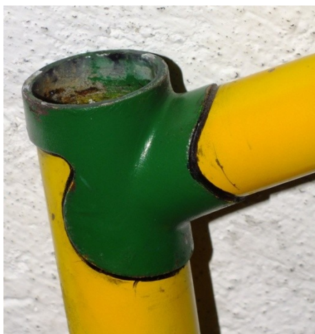
Obr. 27 Spojení trubek rámu kola Favorit
