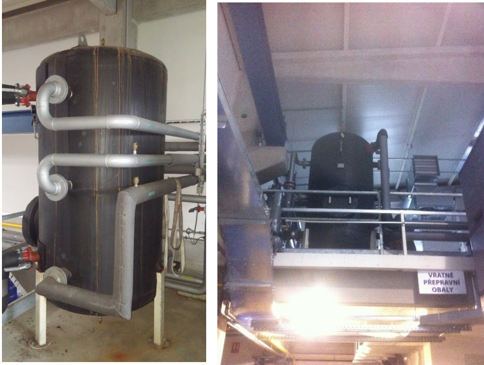
Obr. 5 Akumulační nádrž o objemu 2500 l
