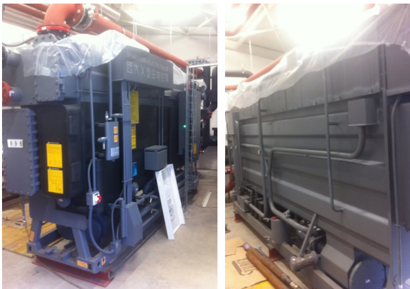
Obr. 10 Pohled zepředu a ze zadní strany chladicí absorpční jednotka BROAD
