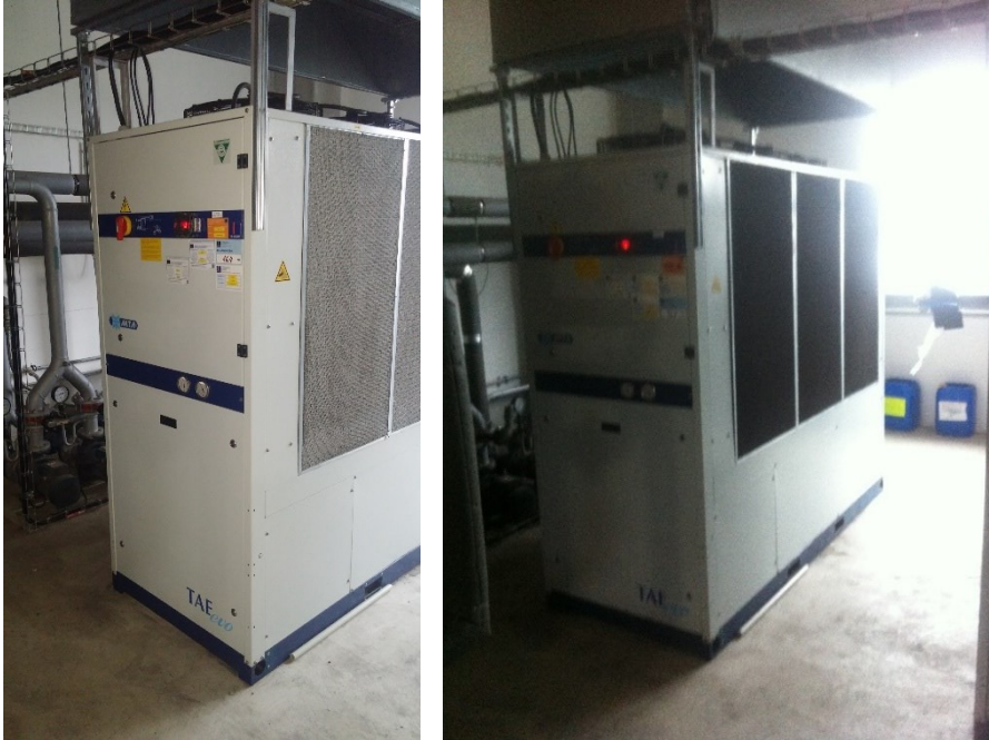
Obr. 3 Původní chladicí jednotka TAEevo 301
