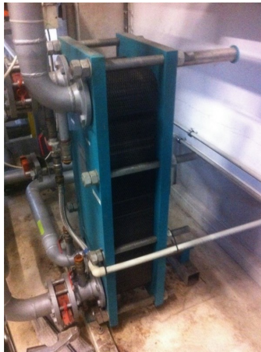
Obr. 4 Původní deskový výměník patřící k akumulární nádrži
