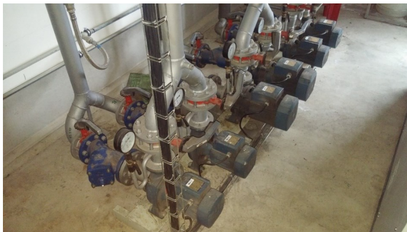
Obr. 6 Čerpadla Pedrollo HF 5AM
