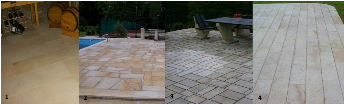
Obr. 15: Příklady způsobů skládání dlažebních desek [24]
