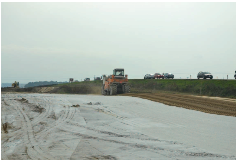
Obrázek 9: Zlepšená jemnozrnná zemina vápnem
