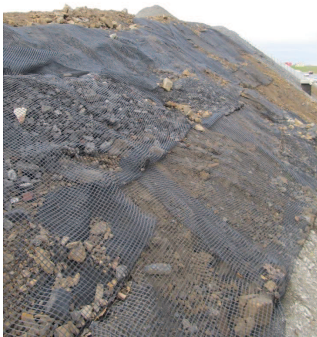
Obrázek 10: Geomříže aplikované na násypovém tělese
