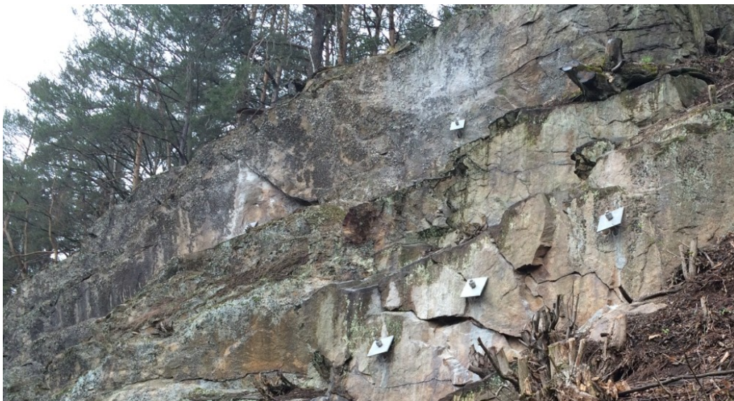
Obr. 9 Kotvení skalního svahu, Budčice I
