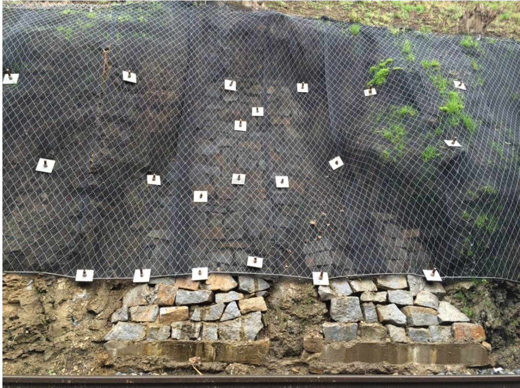
Obr. 23 Skutečné provedení sanace, Budčice II
