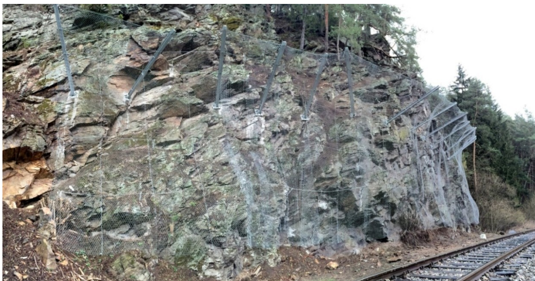
Obr. 17 Ochranné sítě – pasivní, sanace skalního svahu Budčice I
