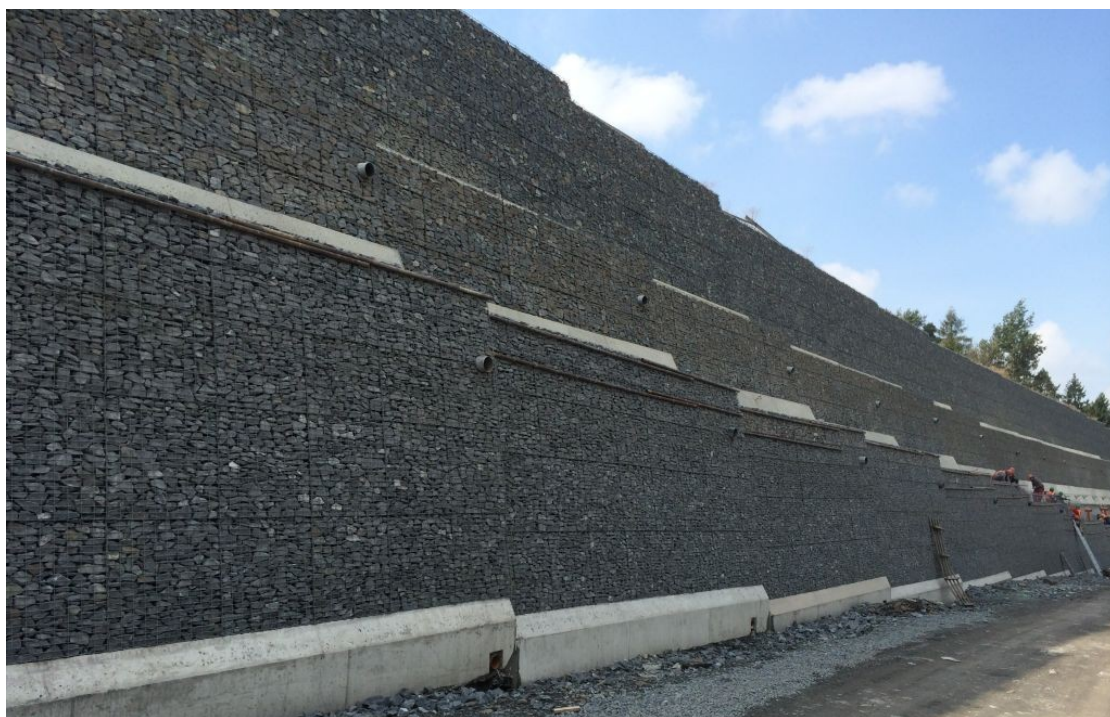
Obr. 11 Gabionová konstrukce, Silnice I/11 Mokré Lazce – Ostrava, [17]
