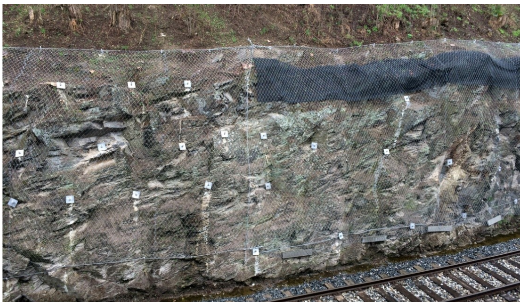
Obr. 16 Ochranné síť – aktivní, sanace skalního svahu Budčice II
