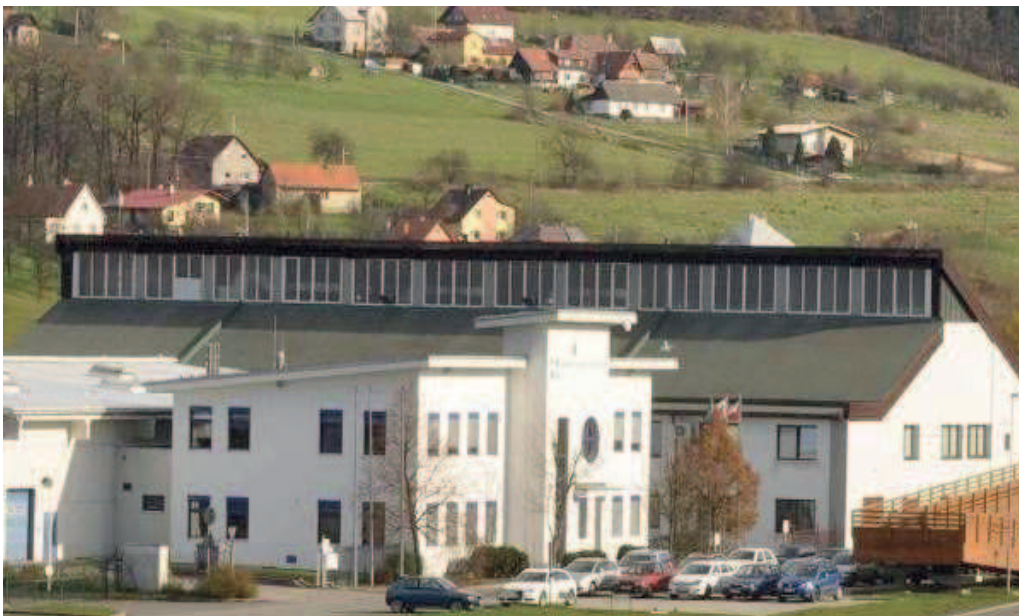
Obr. 3.1 Sídlo společnosti INDET SAFETY SYSTEMS, a.s.
