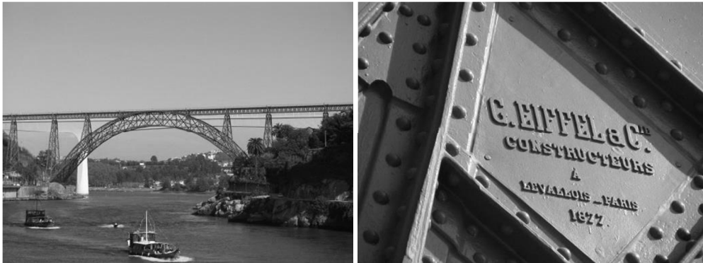
Obr. 1.4 a) Most Maria Pia v Portu, při jehož návrhu byla použita Euler – Bernoulliho teorie nosníků b) „Podpis“ Gustava Eiffela
