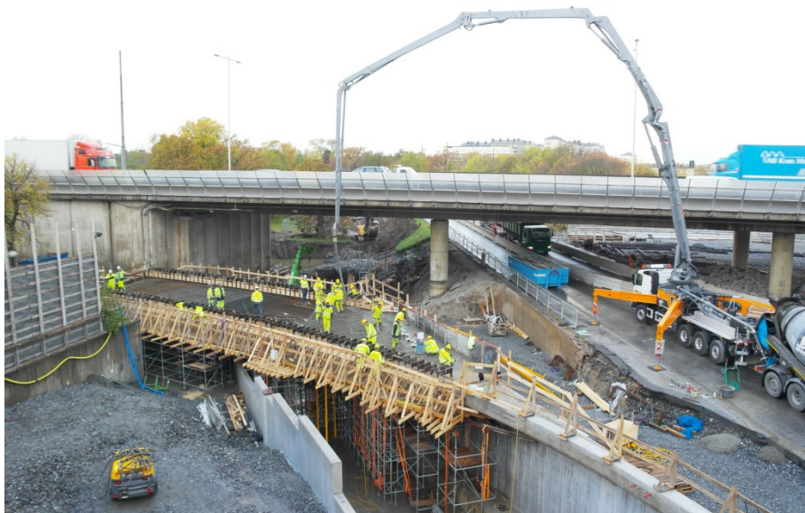
Obr. 1: Betonáž mostovky
