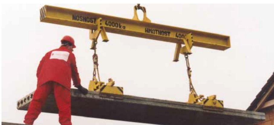
Obr. 18 - Ukázka manipulace se stropním panelem použitím samosvorných kleští [6]
