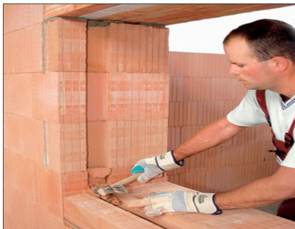
[26] Obr. č. 7 Opatrné vyklepnutí přepážek otvorů
