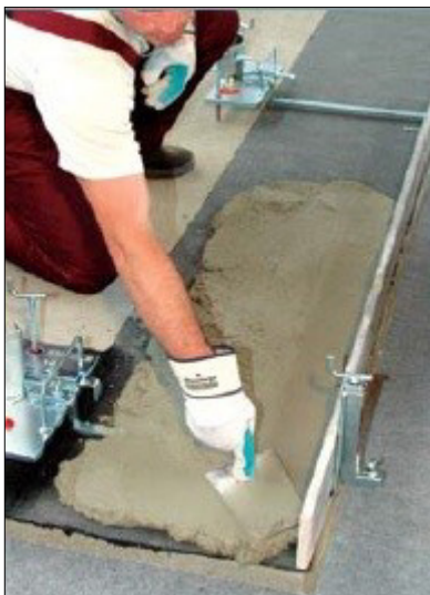
[26] Obr. č. 5 Způsob nanášení maltového lože
