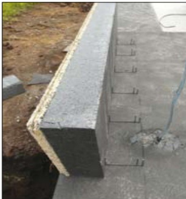
[29] Obr. č. 17 Otočení štěpkocementové desky o 180°
