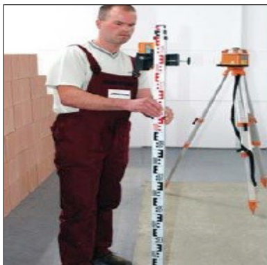
[26] Obr. č. 3 Zaměření základové desky
