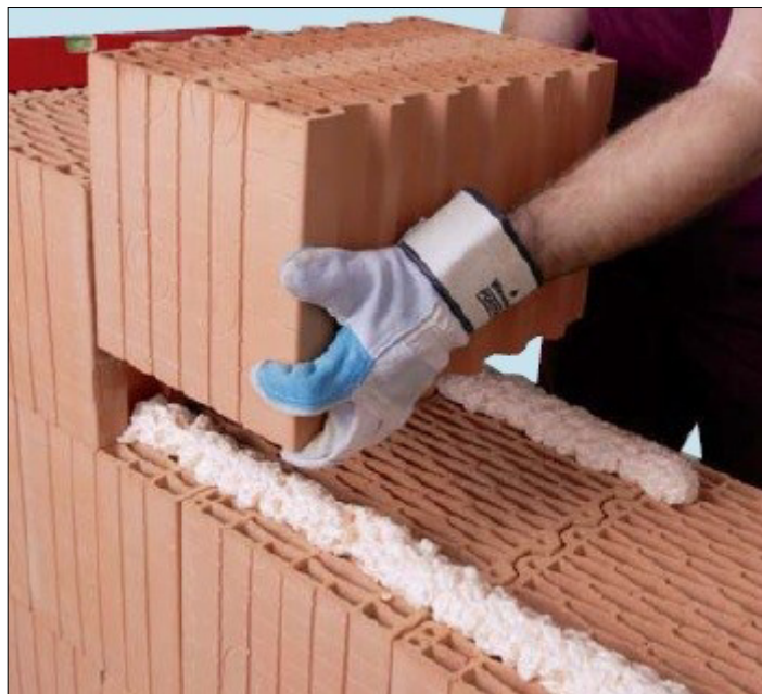
[27] Obr. č. 6 Ukládání cihel na zdicí pěnu
