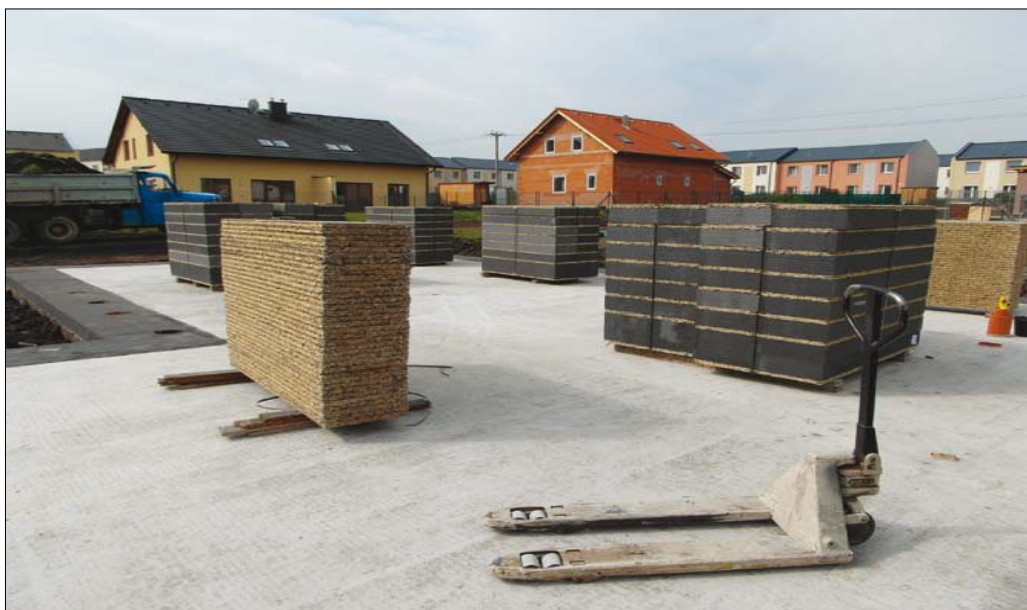
[30] Obr. č. 15 Skladování materiálu
