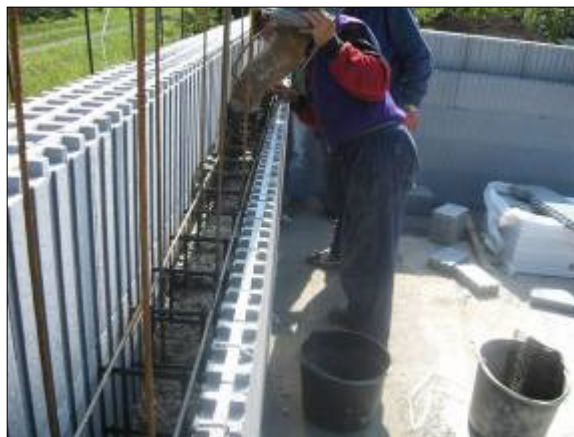
[28] Obr. č. 14 Betonáž
