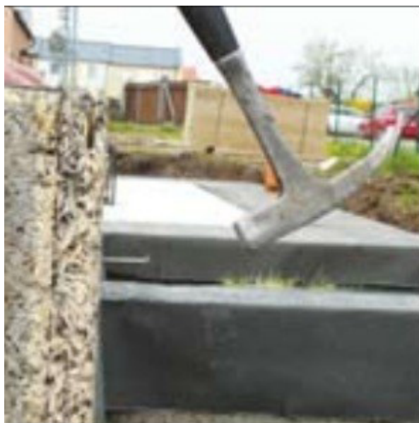
[29] Obr. č. 18 Přibití hřebíkem vnější roh
