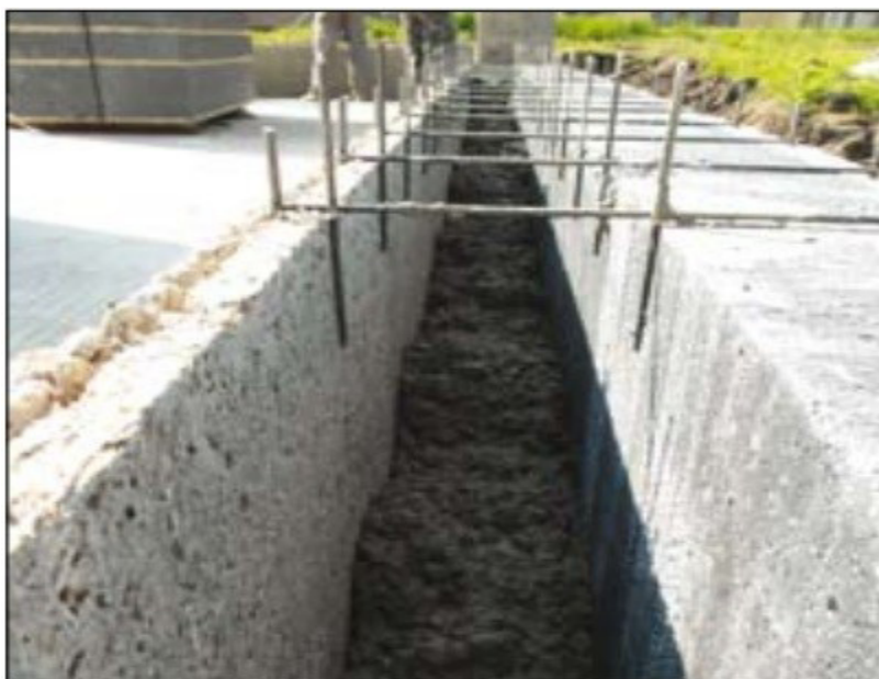
[29] Obr. č. 19 Betonáž
