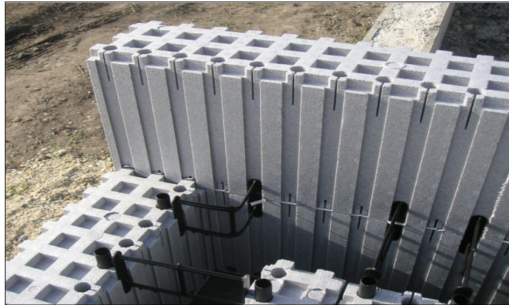
[28] Obr. č. 11 Řešení tvárnic v místě rohu
