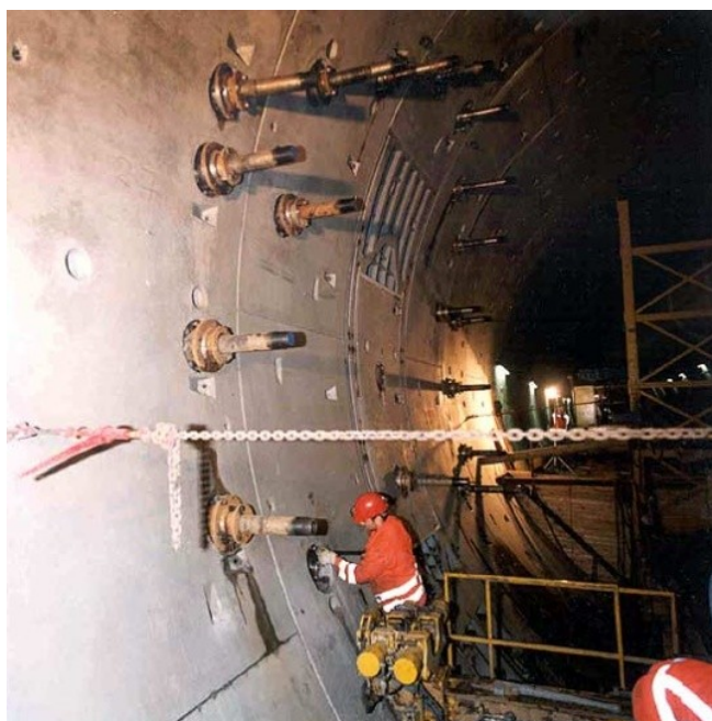
Obr. 30 – Detail zmrazování zemin (roadtraffic-technology.com [23])
