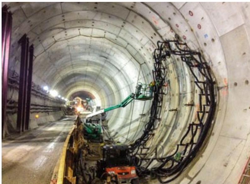
Obr. 29 – Zmrazování zemin v místě tunelové propojky (tunnelingonline.com [22])
