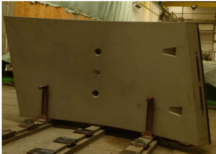
Obr. 14 – Segmentové ostění
