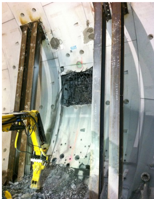
Obr. 21 – Použití tunnelbagru v místě propojky (portofmiamitunnel.com [15])
