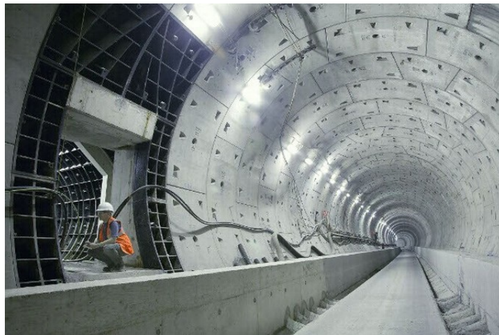
Obr. 22 – Příhradové segmenty v místě prostupu (crossrail.co.uk [17])
