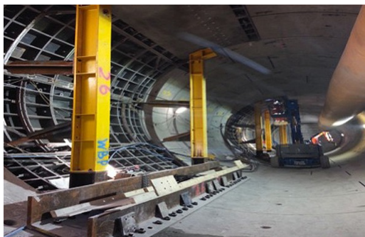
Obr. 23 – Kombinace dočasného podepření a litinových segmentů (powersystems-services.co.uk [18])
