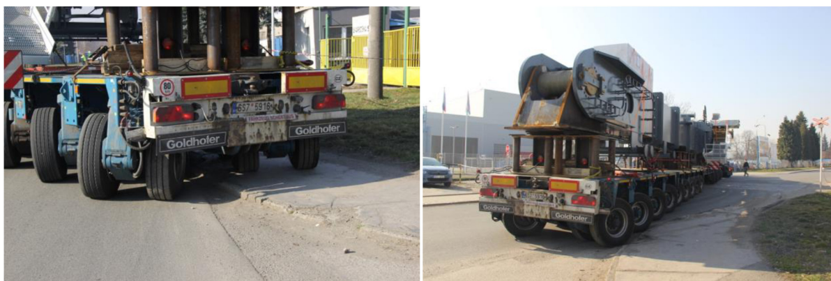
Obr. 17 Přejezd soupravy přes chodník
