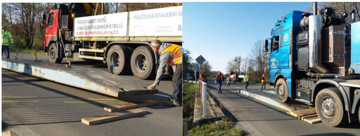
Obr. 36 Ukládání přejezdových ramp a následné přejetí nákladu přes most
