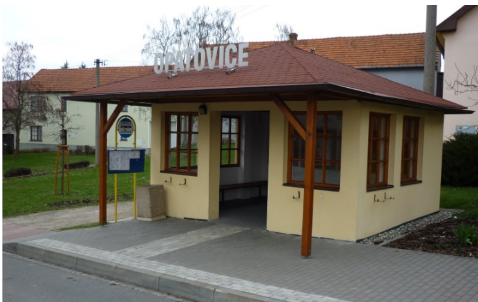
Obr. 2.6 Opravená autobusová zastávka Opatovice
