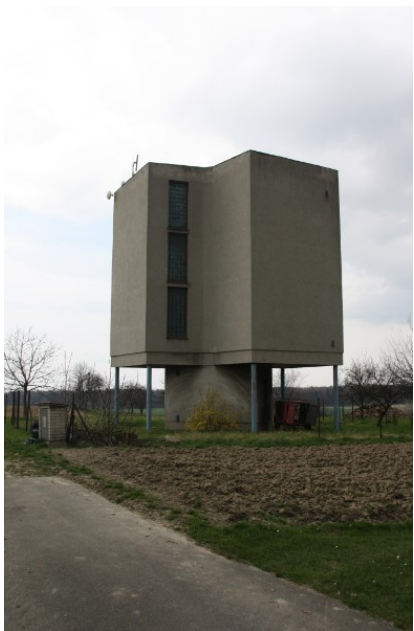
Obr. 4.2 Budova Starého vodojemu
